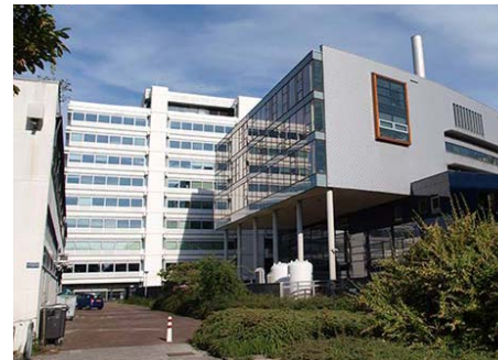
Boven: het opnieuw gebruiken van de entree op de verhoogde route is noodzakkelijk. Hierboven: achterkanten, zichtbare installaties en hekwerk zijn onwenselijk.
